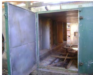
Figure 48: Chambre de séchage
