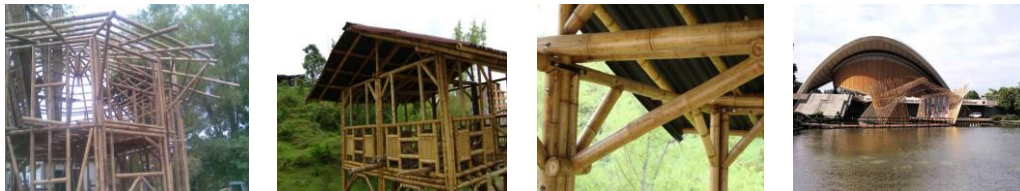
Figure 24: Bambou géant utilisé en tant que matériaux de construction après traitement chimique uniquement.
