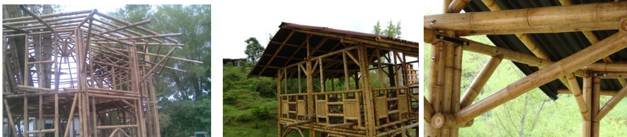
Photo 4 : Bambou géant utilisé en tant que matériaux de construction après traitement chimique uniquement.
