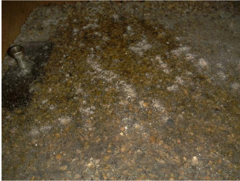
Photo 26. Béton de résine
