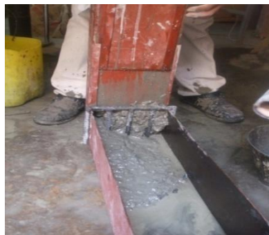
Photo 3 : Essai à la boîte en L
